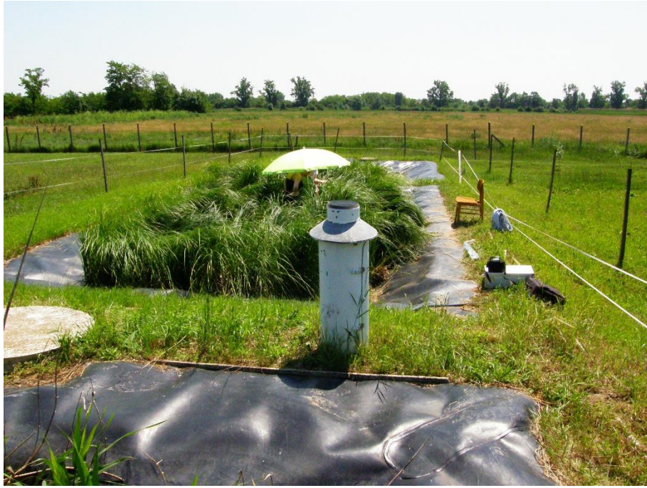
45. ábra: Hosszanti átfolyású gyökérszórás műtárgy (fotó: Somfai Dávid, 2016.07.07.)
