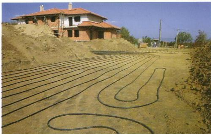
2.19. ábra Talajkollektor kivitelezése (Komlós et. al. 2009)
