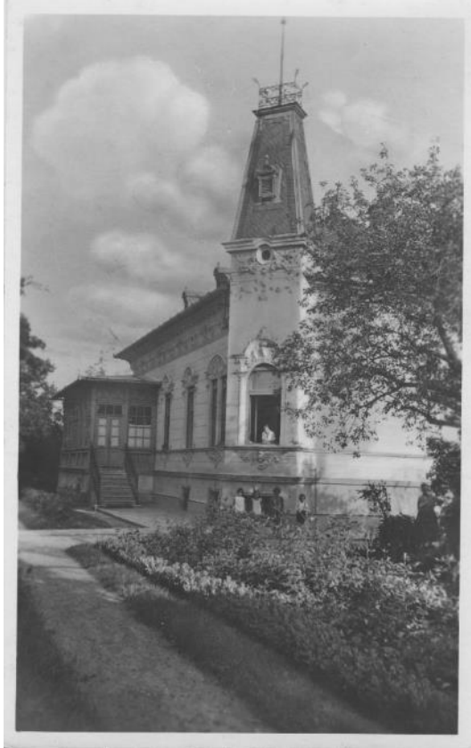
179. Rákospalota Nyarló, Damjanich u. 54., Szepessy-villa, 1930 k. (Fővárosi Szabó Ervin Könyvtár - Budapest Gyűjtemény)
