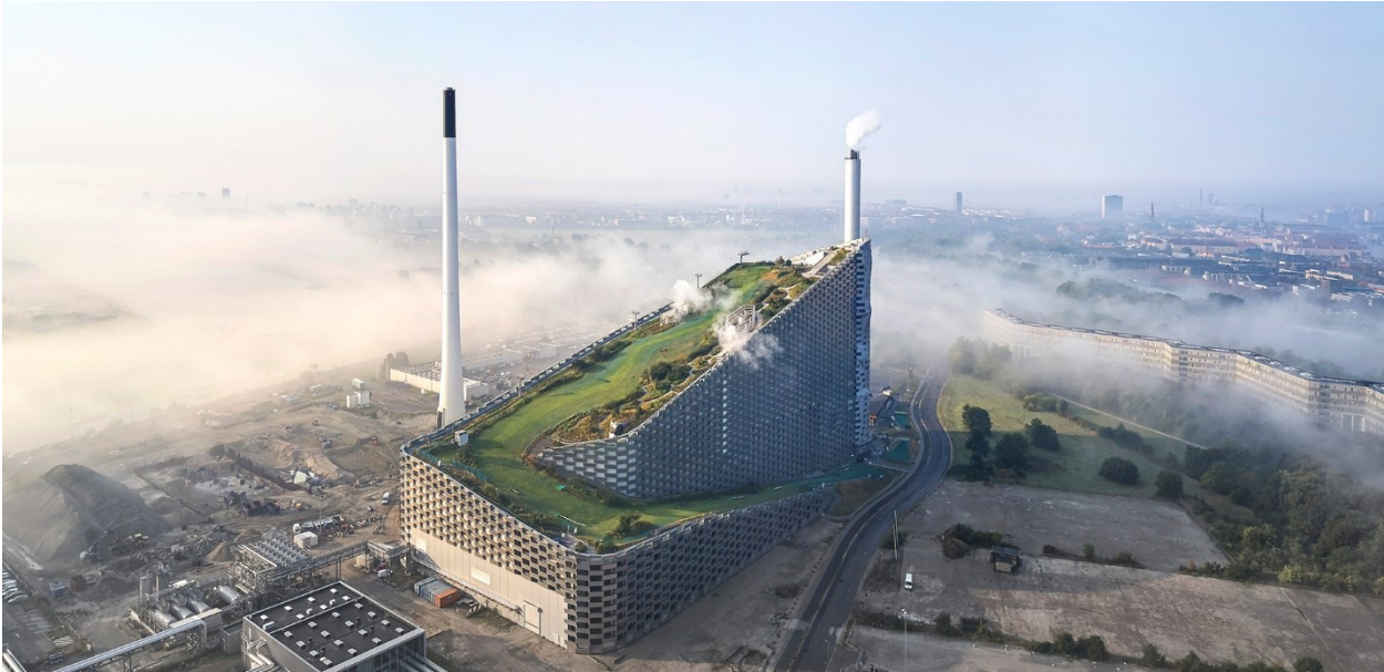
10.06. ábra Műsípálya a szeméttégető tetején. Bjarke Ingels Group: Amager Bakke. Koppenhága, 2020.
