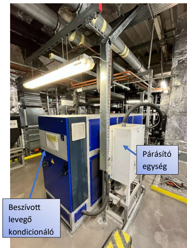
3.4. ábra Töltetlevegő előkészítő egység (Forrás: Biró Norbert)
