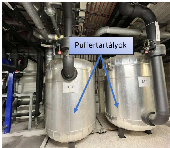
3.2. ábra Hőcserélő puffertartályok (Forrás: Biró Norbert)
