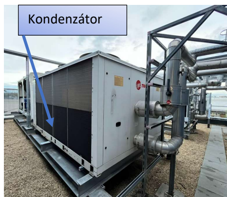
3.3. ábra. Hűtőkör kondenzáló egység (Forrás: Biró Norbert)
